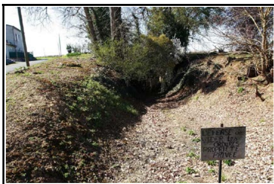
Figure 1-18a et 1-18b : Entrée de la carrière de Saute qui peut (photos Duhazé B.)
