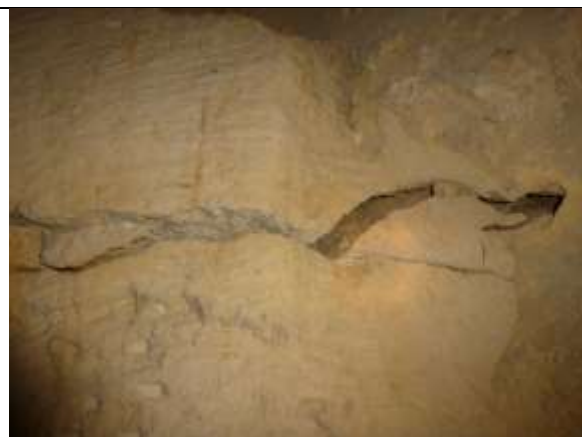
Figure 14 : Exemple de fissure dans une carrière souterraine
