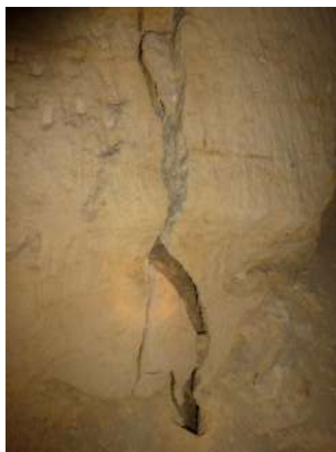
Figure 19 : Fissure à l'intérieur d'une carrière pouvant provoquer l'effondrement du plafond
